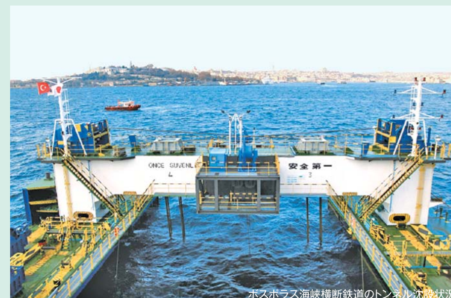
ボスポラス海峡横断鉄道のトンネル建設状況
