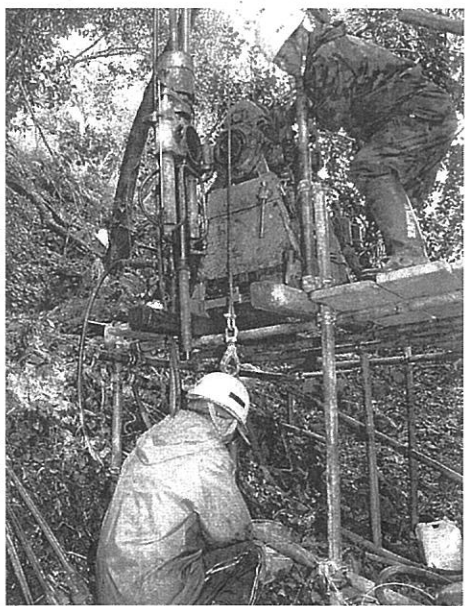
シェルター設置の地質調査で行われたボーリング作業 (室戸市佐喜浜町)
