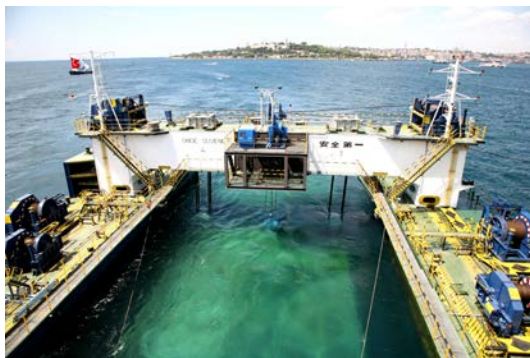
沈埋トンネル設置状況
