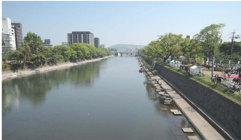
整備後の大甲橋からの風景
