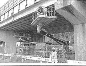
高所作業車に搭乗して打音検査を行った
