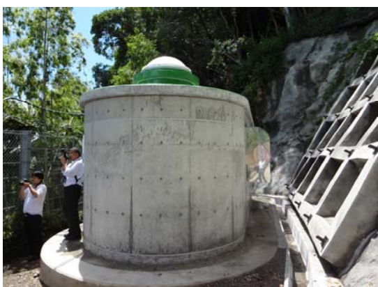
立坑上部の外部連絡口上屋
