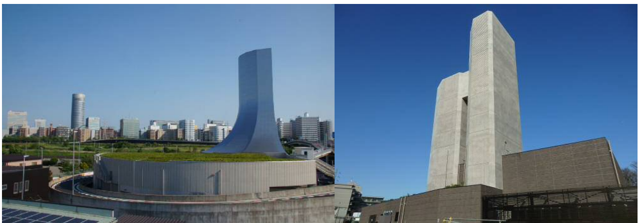
新横浜換気塔、馬場換気塔
