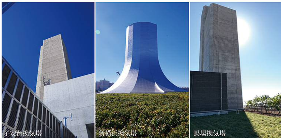
横浜北線のトータルデザインコンセプトと換気塔
