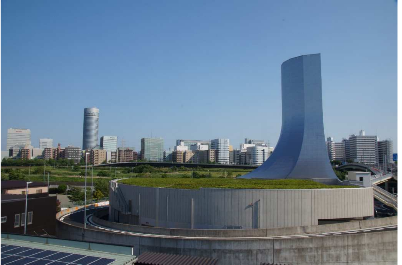
新横浜換気所
