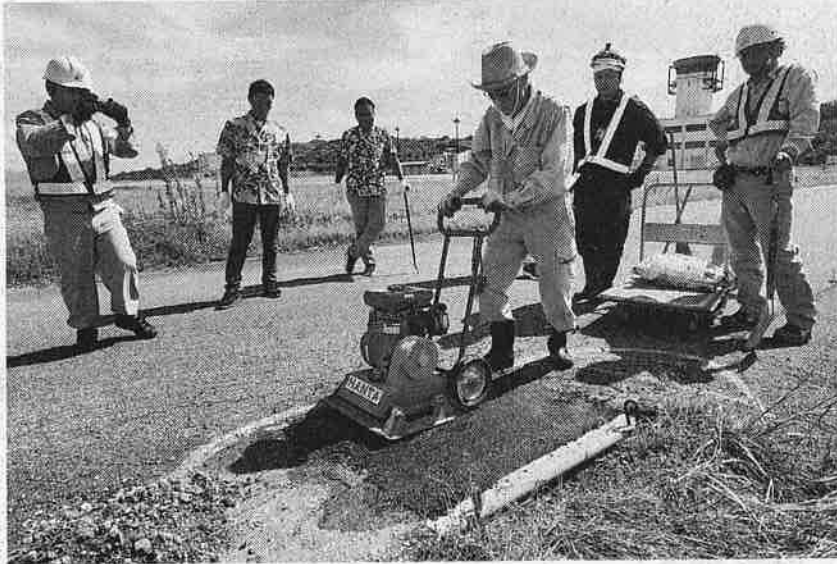
ひび割れた場所の修繕を試す南紀白浜エアポートの社員ら (白浜町の南紀白浜空港で)
