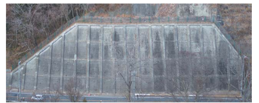
ドローンに搭載した高解像度カメラで撮影したのり面
