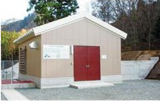
米沢大平小水力発電所建屋
