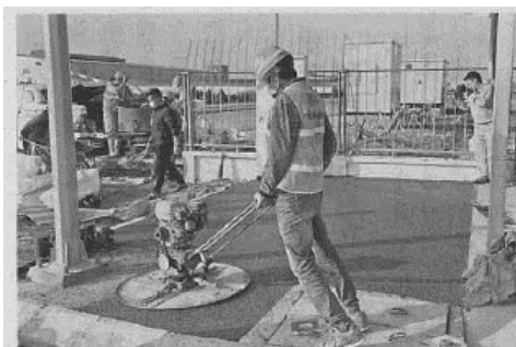
ベトナム・ハイフォンでの試験施工の様子
