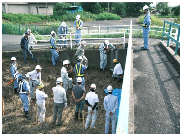
ひびわれ補修の実演（桁下）
