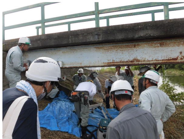
断面修復工の実演（桁下）
