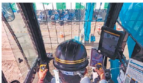
国土部ICT施工データ変換システム(eMS)の効果も実証済み
