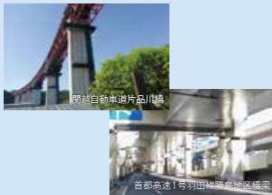
「首都高羽田線」の大規模修繕設計・「片品川橋」の耐震補強設計(平成28年度田中賞の作品部門を受賞)
