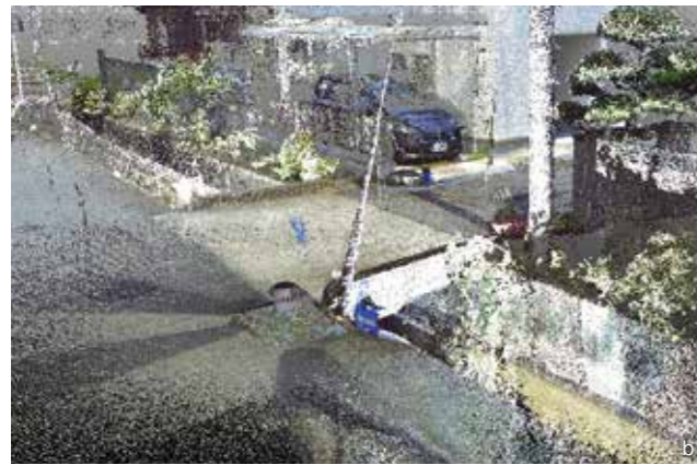
a. 架設状況 b. 既設橋梁の点群データを活用 c. 田原本町での検討会の様子
