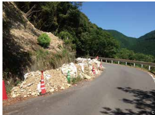
a.総ストック点検対象箇所抽出概念図 b.対策実施例 c.法面对策要対策箇所での車道まで到達した小規模崩壊状況例 d.GISを活用したデータの可視化の概念図
