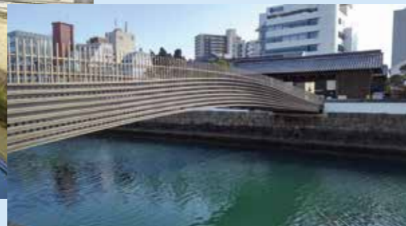
河川の中に柱を設けず、片持ち梁のように橋全体を支持
