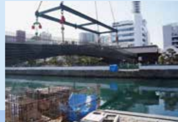
大型クレーンによる上部工架設の様子
