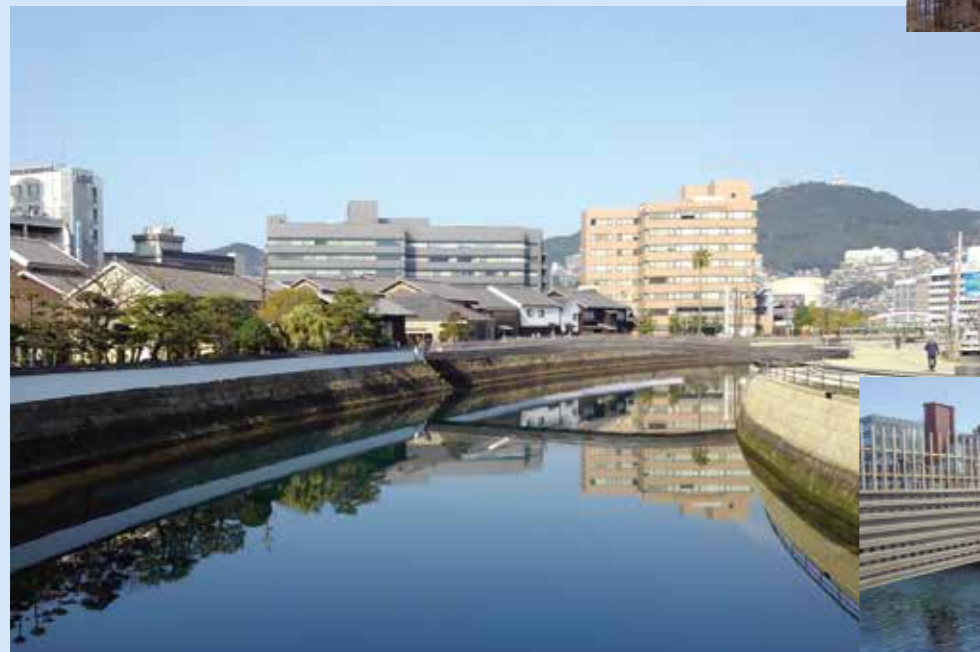
出島表門橋全景
