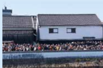
上部工架設を見守る地元の方々
