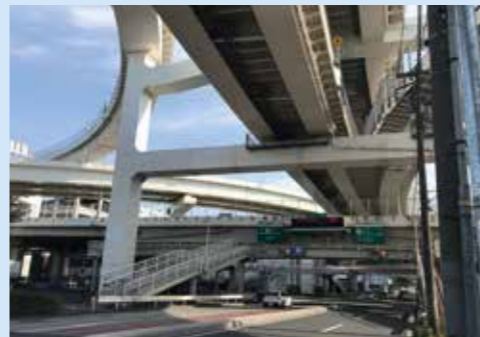
既設の橋脚に対する補強も実施
