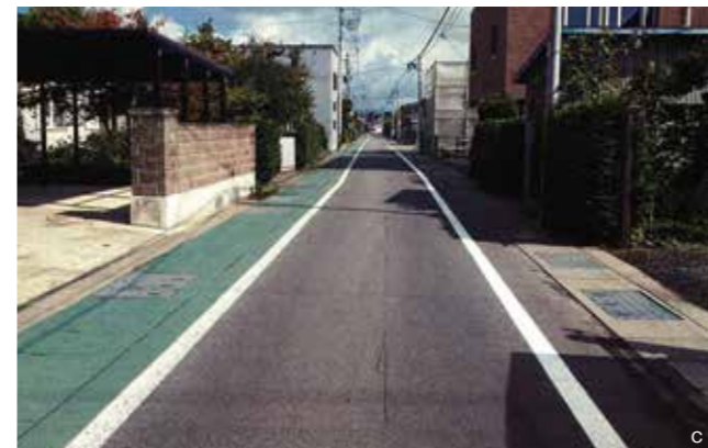
a.通学路合同点検の様子 b.生活道路の交通安全対策協議会の様子 c.追加対策前・路面標示（ゾーン30）を設置した道路（弘前市） d.追加対策後・車道幅員を狭めた（3.0m→2.5m）道路（弘前市）
