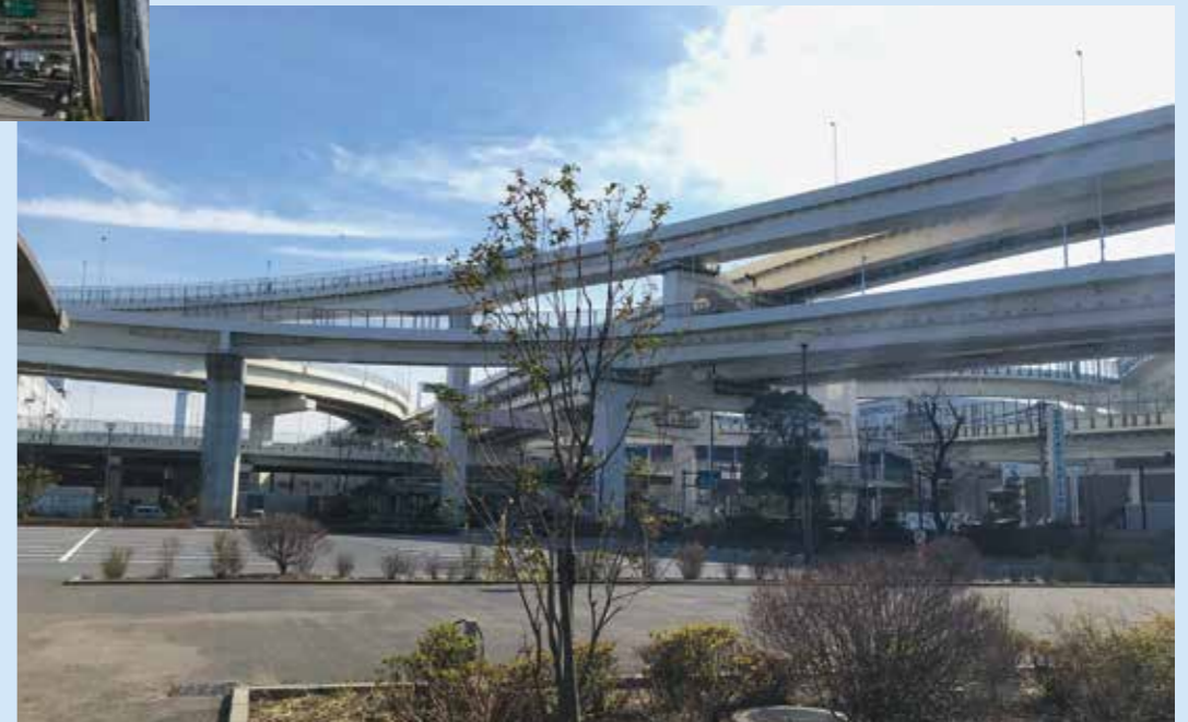
狭小空間に完成した巨大ジャンクションの全景
