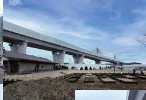
温泉側には目隠し板を設置
