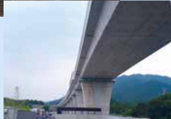
鉄道・国道との交差点で安全性を検証
