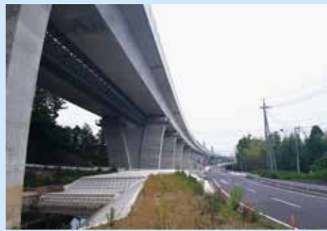
名古屋側から見た橋脚部
