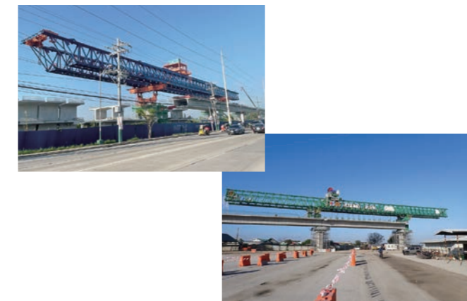
マニラ首都圏の南北通勤線の鉄道高架橋。2025年の全線開通を目指す。
