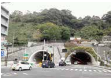
社会資本の老朽化が進む中で、戦略的な維持管理・更新を推進することが必要となっており、「国民の命を守る」観点からもインフラ保全は急務の課題となっている。
