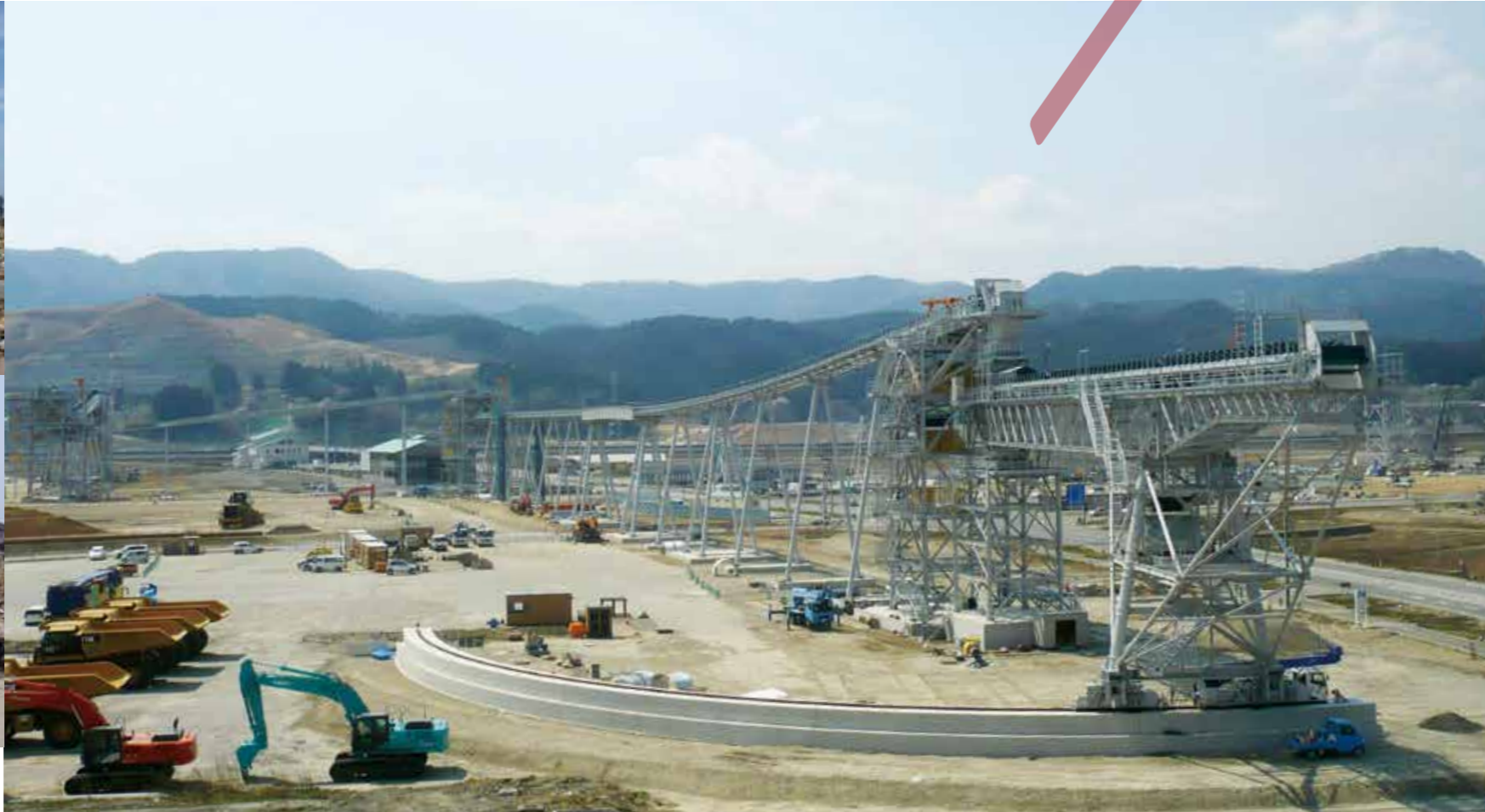
右) 陸前高田市の高台を造成するため、山の土を切り出してベルトコンベアで運ぶ。 左上) 震災直後の名取市。 左下) 震災直後の石巻港。船が岸壁に座礁している。
