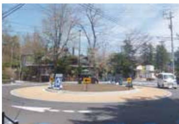
軽井沢町六本辻は、6枝の無信号交差点をラウンドアバウト運用に改良。ラウンドアバウトにしたことにより、自動車走行の円滑性と、歩行者、自転車の安全性が高まった。
