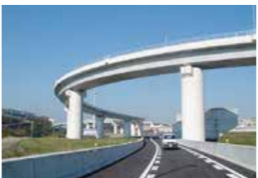
OCが設計を担当した、日進ジャンクションBランプ橋（PC箱桁橋）の完成写真。日進ジャンクションを含む、名古屋瀬戸道路全体の建設の執筆者、取りまとめも実施。
