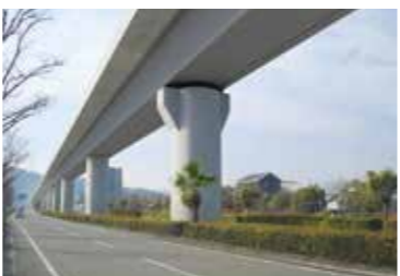
高知南国道路のうち、高知美術館前の橋梁です。設計コンセプトは、「美術館入口のリズムも持ったゲート性」とし、鋼3径間連続ラーメン開断面箱桁橋を連続させ(3連)、上下部剛結構造による梁レス、円柱橋脚により、リズム感、ゲート性を演出。
