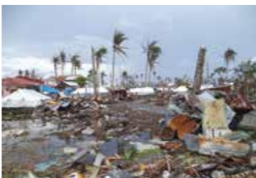
2013年11月8日レイテ・サマール島各地に大きな被害をもたらした台風ヨランダ。現在OC Globalでは、同台風災害緊急復旧復興支援プロジェクト(開発調査・無償協力)を実施中。
