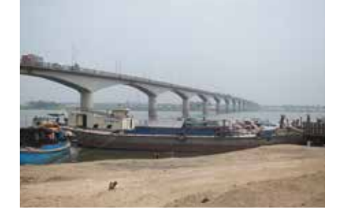
1995年に日本の無償援助で建設された既存グムティ橋。
