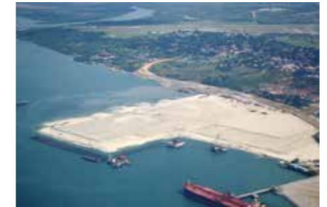
埋立てて新ターミナルを建設。手前に見えるのが、既存のコンテナ岸壁。
