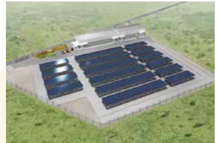
風力・太陽光発電の出力変動抑制、負荷平準化を実現する。
