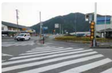
交通事故対策業務において設置を検討した「横断者感知式注意喚起システム」。現在、高知県で2箇所に設置している。
