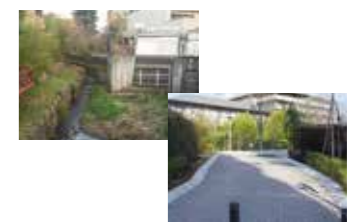
左)堰に設置されたゲート施設。 右)狭小な施工ヤードという悪条件を、新たな技術で克服した。
