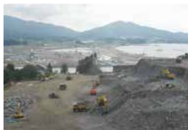
盛土による高台の造成には、長い期間を要した。
