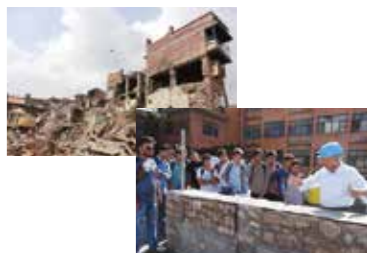
左)震災直後の被災状況。市街地にはレンガ造りの古い建物が多く、被害は甚大だ。 右)再建に向けた耐震モデルハウスが住民に周知された。
