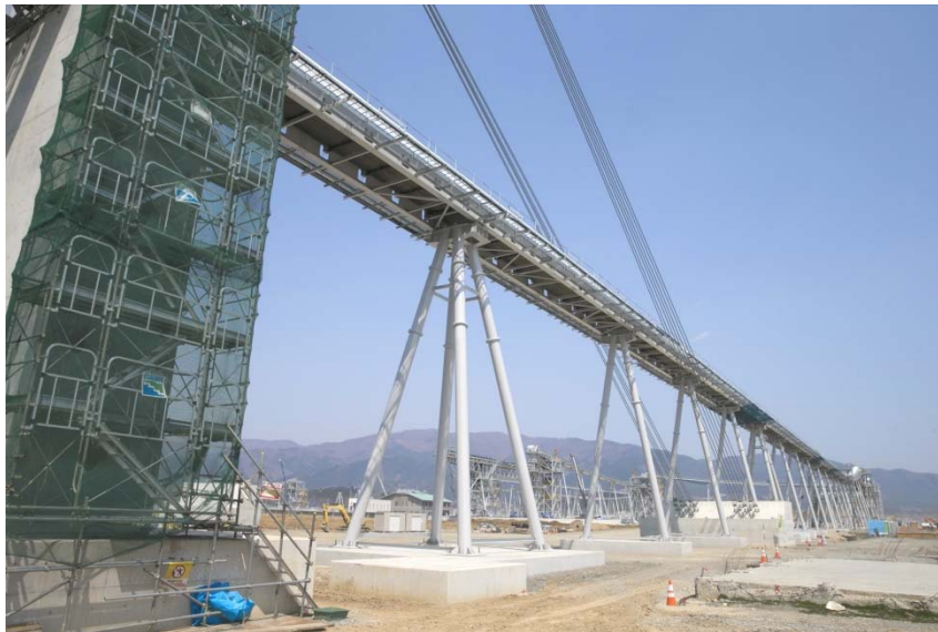
▲巨大ベルトコンベアの導入により、急ピッチで盛土工事が進んでいる
