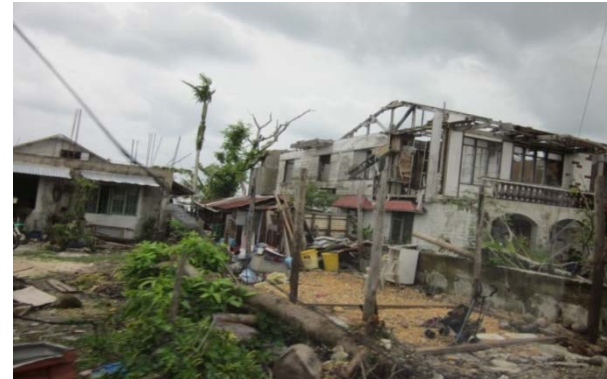
暴風で屋根が吹き飛ばされた家屋
