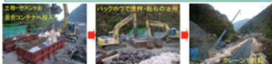
砂防ソイルセメント工法は、砂層が深い場合は施工ヤードの確保が困難と判断され、活用されない事例が多く見られますが、施工方法を応用することでコンクリートよりも経済的に施工することが可能である。砂防ソイルセメント工法の流動タイプは、コンクリートと同様に有スラング材であるため、クレーンで打設が可能です。また、現場で発生した骨材(φ1m以下程度の粗石)についても活用できます。
