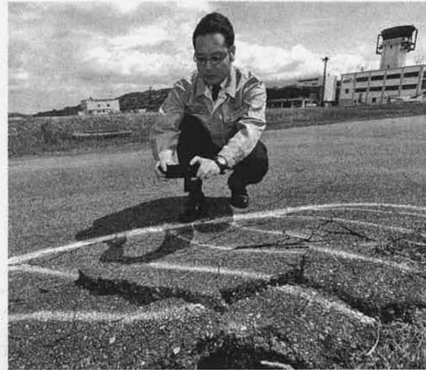
路面のひび割れをスマートフォンで撮影する南紀白浜エアポートの社員（白浜町の南紀白浜空港で）
