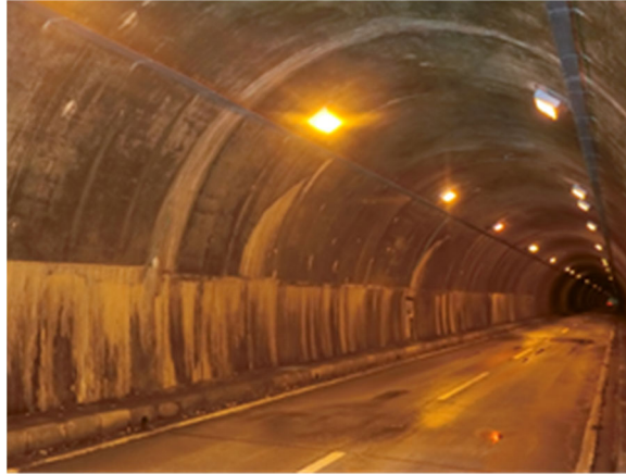
補修前の糠越隧道
