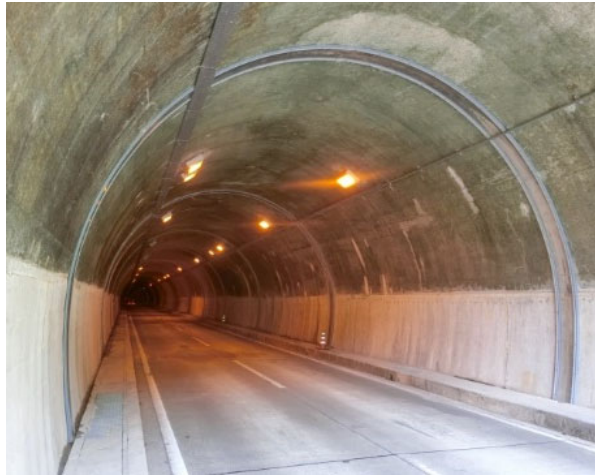
補修後の糠越隧道
