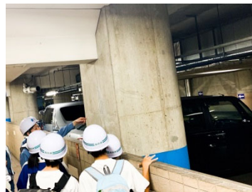
ひび割れ幅測定
