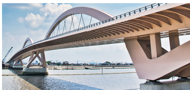
有明筑後川大橋
