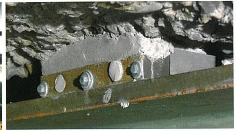
鋼製補強材による既設床版仮受
