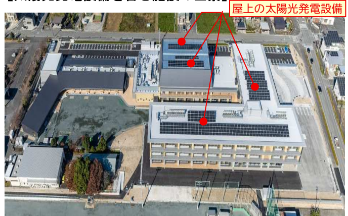
【太陽光発電設備を含む施設の全景】
