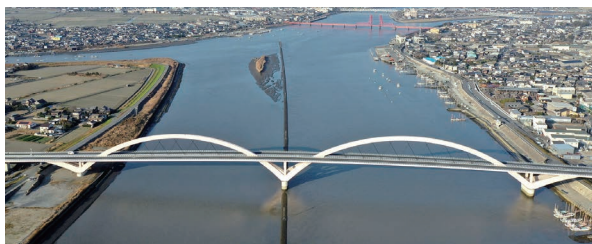
中央のデ・レイク導流堤に橋脚を設置し筑後川を横断する有明筑後川大橋
