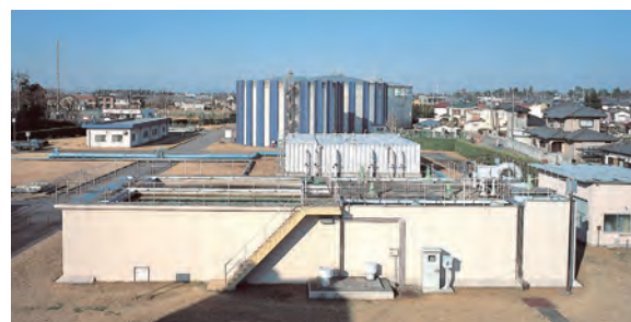
浄水された水を受水し、各家庭に配水するための守谷配水場。
