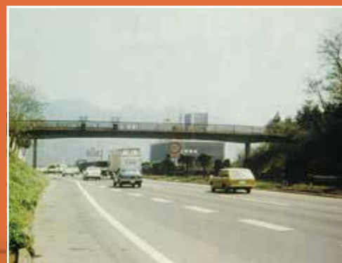
PC斜材付n型ラーメン形式跨高速道路橋(名神高速道路)は、我が社の高い技術力を示した(1960年)。
