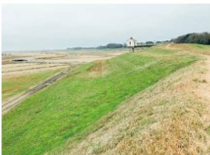
田中調節池の様子。普段は農地として利用されているため、再整備にあたっては関係者との合意形成にも苦労したという。
