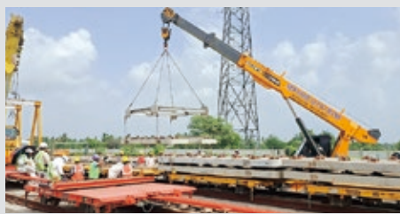
実習（軌道スラブ施工）風景
