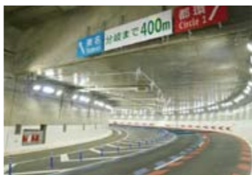
大橋JCTは、最大約70mの地下トンネルと高架を接続する。ドライバーを安全に誘導するため、カーブの形状に応じた赤・青のカラー舗装をはじめ、看板や安全施設などをトータルにデザインした。
