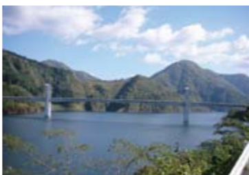
徳山ダムの両岸をつなぐ徳山6号橋。コンクリートだけのエクストラードード橋では日本一の規模を誇る。規模の割に橋桁が薄く、地域の景観を損なわない配慮がなされている。
