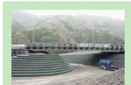
▶平成23年の台風による被害を受け、五條新宮道路の復旧対応に従事。地域孤立の解消、主要幹線道路の機能回復など復旧復興に貢献した。写真は応急復旧橋梁。
