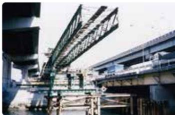
橋梁架替は、現況6車線を確保するため上下流に仮橋を設け、現橋半断面毎の撤去・架け替え。上部工は鋼床版箱桁で、架設工法は送り出し架設工法とした。
