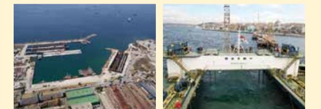
製作した函体を海上に曳航し、海底へと沈設させる一連の業務には高度な技術が必要となる。
