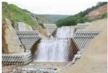
計画から5年がかりでついに完成した砂防堰堤。堆積した土砂の上に造る必要があったため、フレキシブルなコンクリートブロック構造を採用した。
