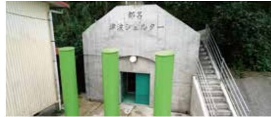
高知県室戸市津波避難シェルター
