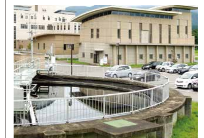
大野市下水道処理センター [福井県大野市]
