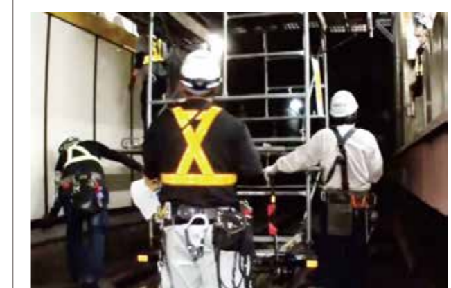
駅舎点検の現場写真(「賢者の選択」より引用)
